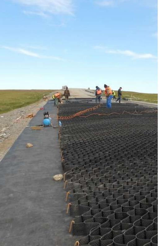
ROAD PAVEMENT, EMBANKMENT SLOPE REINFORCEMENT. LINE SERVICE ROAD «COMPRESSOR STATION VORKUTINSKAYA - COMPRESSOR STATION YARYNSKAYA», GAS TRANSMISSION NETWORK «BOVANENKOVO – UHTA», 2013-2014
